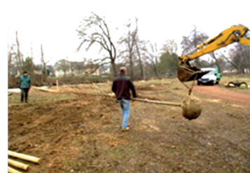
Janvier 2019 : mise en place sous un ciel clément
